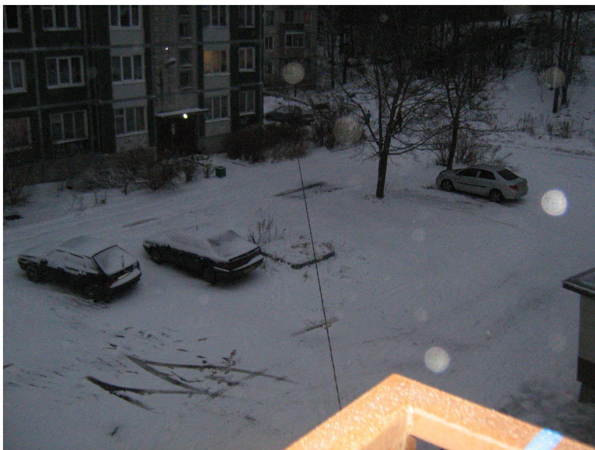
Средневолновая передающая антенна "наклонный луч" длиной 45,5 метра. Вид с площадки пожарной лестницы. Сделана из полевого телефонного провода П-274. Дальним концом она уходит на крышу здания напротив.
